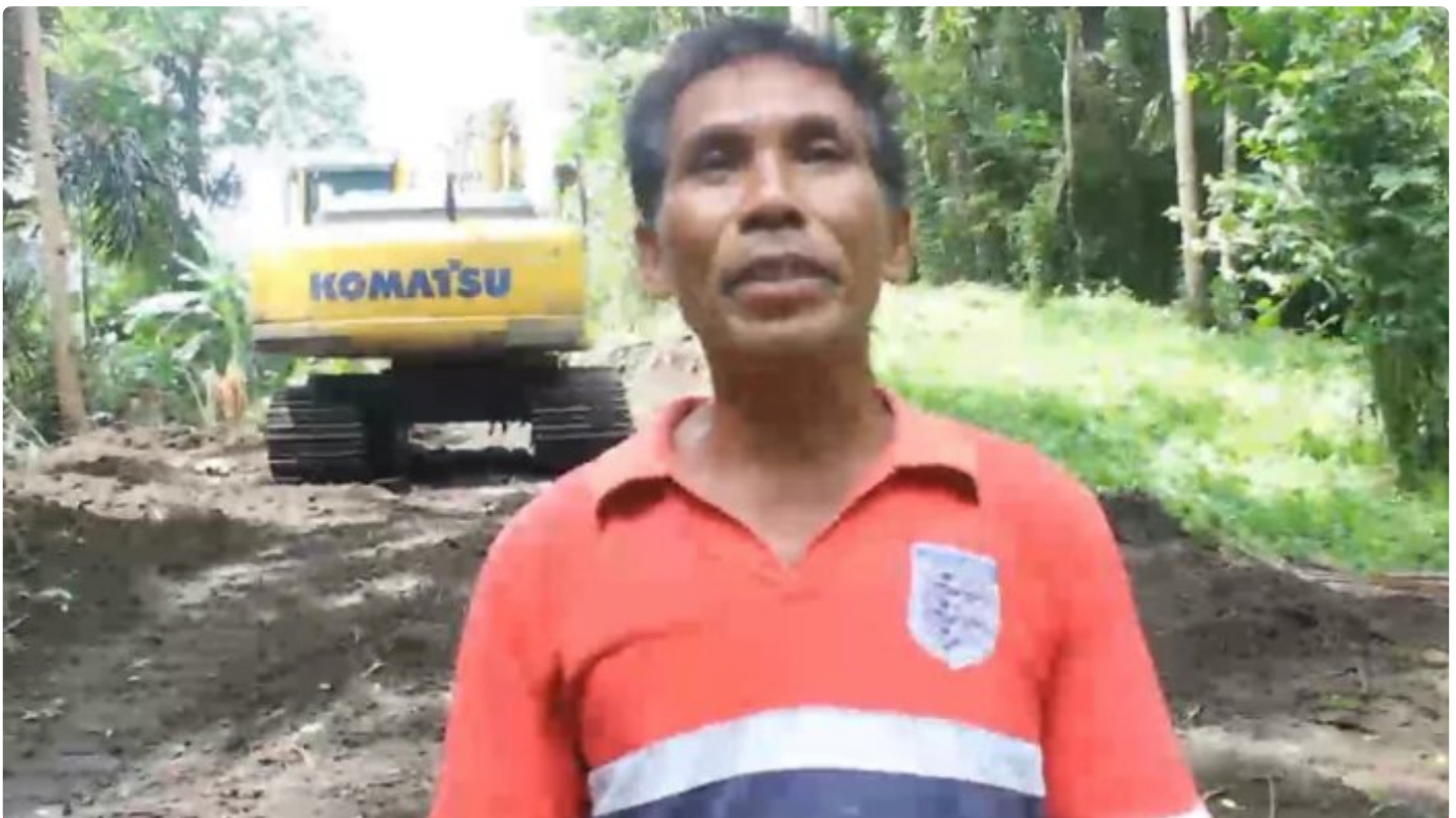
Galvi Karaki, Pemilik Lahan Lokasi Pembukaan Jalan TMMD Ke 116 Kodim 1310 Bitung
